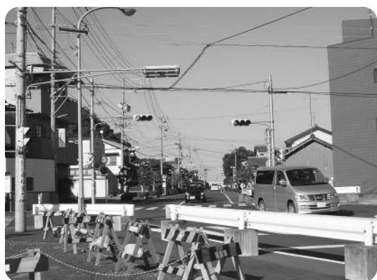
工事が進む山の手幹線（静波）
