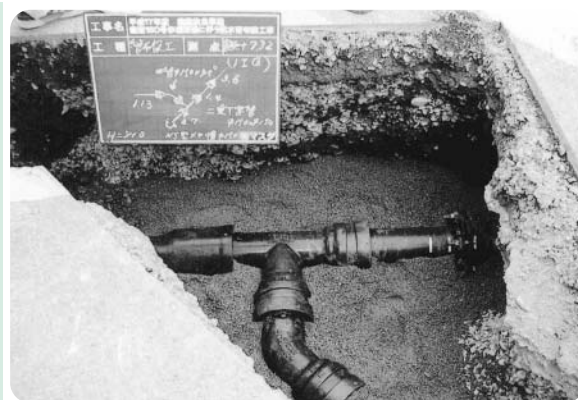
布設替えが済んだ幹線水道管
